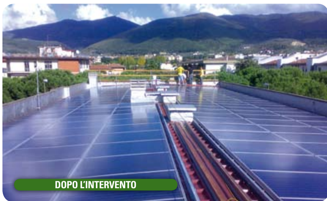
Sul tetto dell’edificio di viale Ariosto 29-47 è stata sostituita la copertura in eternit con un nuovo tetto dotato di impianto fotovoltaico.
