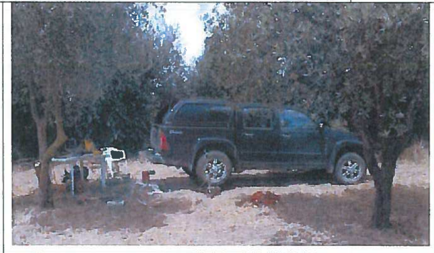
Figura 2 Approntamento cantiere nei due punti di misura SN1 e SN4
